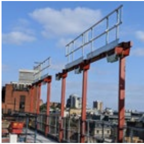
Microcolumns + slab edge beam
